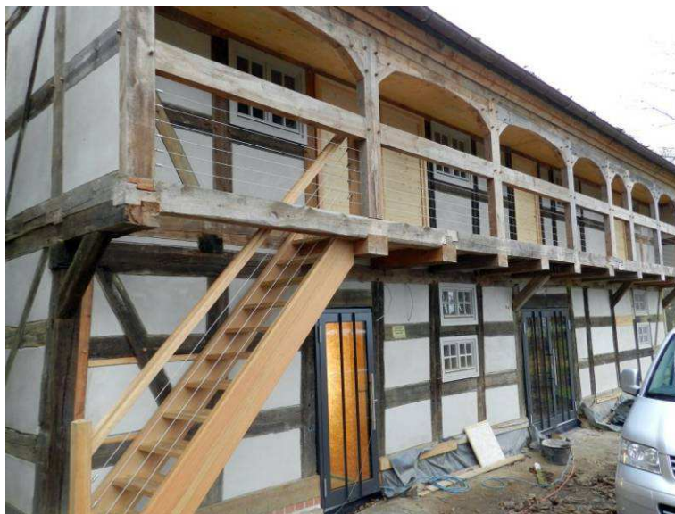
Oberlaubenstall nach der Sanierung
