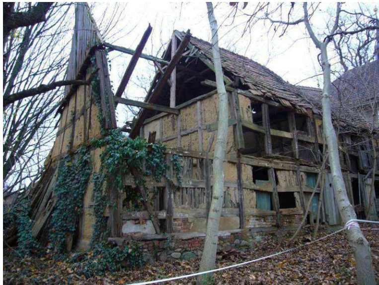
Oberlaubenstall vor Beginn der Sanierung
